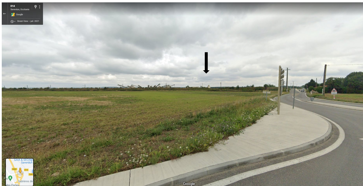
Vue éloignée sur la centrale fixe et la zone d'implantation de la centrale mobile depuis l'intersection entre la RD14 et la RD820 (Google Streetview, novembre 2021)
